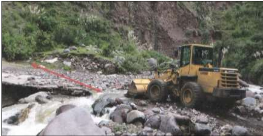
Maquinaria pesada trabajando en zona afectada
