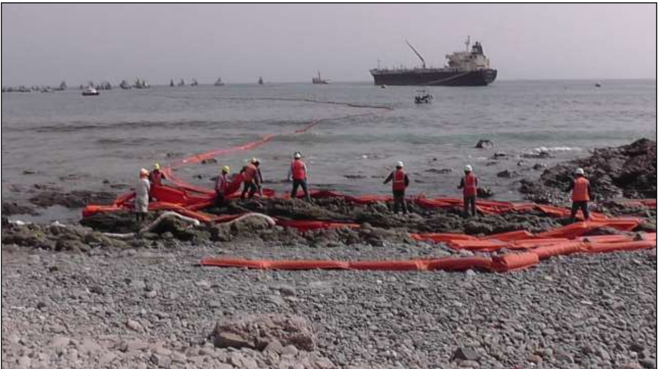
Colocación del muro de contención absorbente, alrededor del área afectada.
