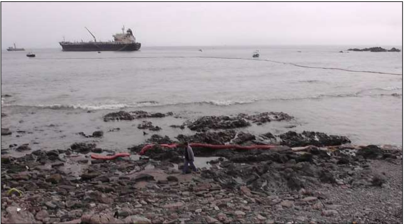
Colocación del muro de contención absorbente, alrededor del área afectada.
